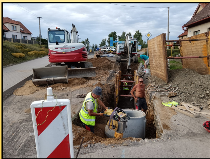
Napojení nové kanalizace do stávající kanalizace u č.p. 133
