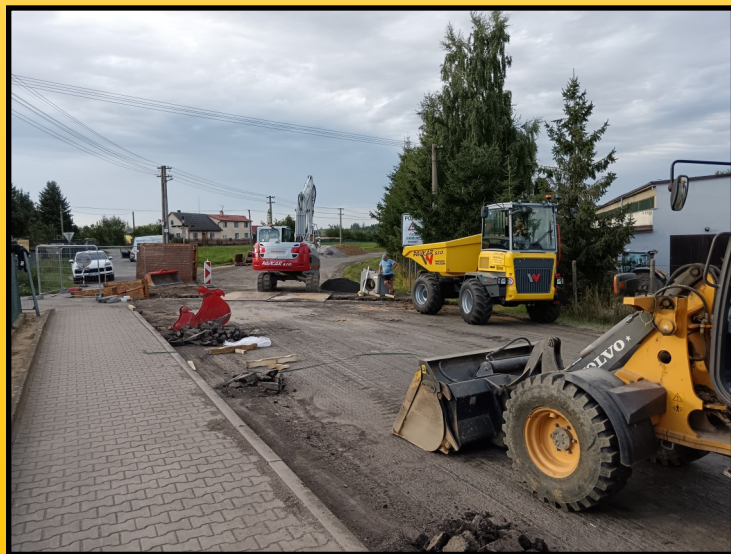
Prostup kanalizace pod silnicí č. 354 u společnosti ZERAS a.s.
