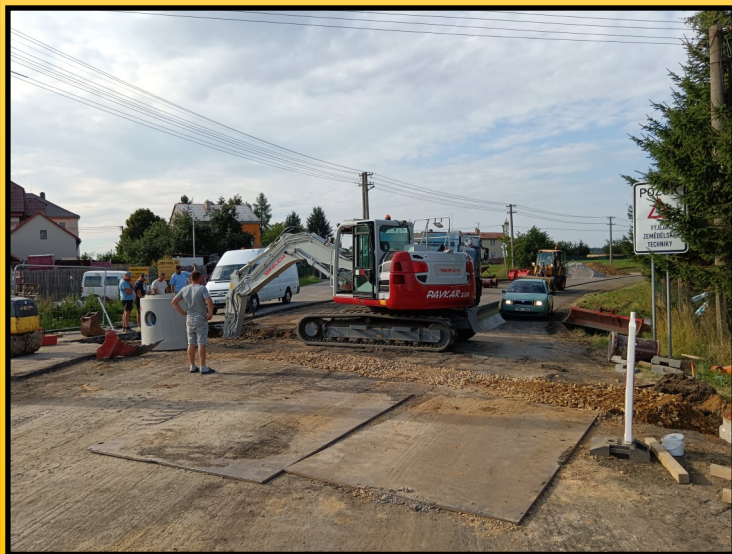
Prostup kanalizace pod silnicí č. 354 u společnosti ZERAS a.s.
